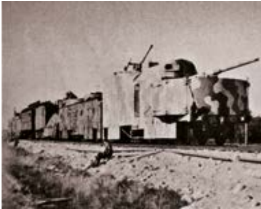
Vasemmalla panssarijuna radankorjausjunaa suojaamassa Itä-Karjalassa. Mukana vallatun venäläisen panssarijunan tykki-vaunu. Oikealla suomalainen panssarijuna ja veturi nro: 884 Karhumäessä talvella 1942. Höyryveturin savu ohjattiin putkea pitkin veturin taakse, jotta se ei olisi paljastanut junaa. Kuvat: Veturimies-lehti.
