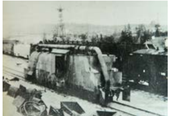
Vasemmalla panssarijuna radankorjausjunaa suojaamassa Itä-Karjalassa. Mukana vallatun venäläisen panssarijunan tykki-vaunu. Oikealla suomalainen panssarijuna ja veturi nro: 884 Karhumäessä talvella 1942. Höyryveturin savu ohjattiin putkea pitkin veturin taakse, jotta se ei olisi paljastanut junaa. Kuvat: Veturimies-lehti.
